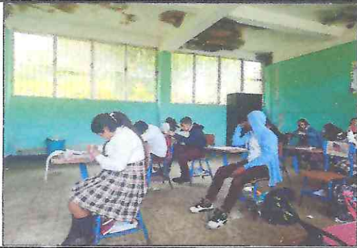
Foto 1: Interior Aula de Segundo Básico
