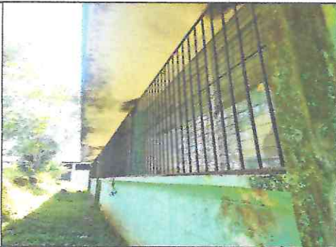
Foto 5: Parte trasera de una de las aulas
