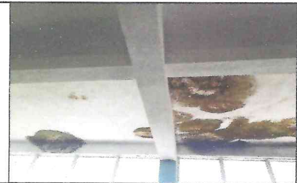
Foto 4: Interior de Aulas
